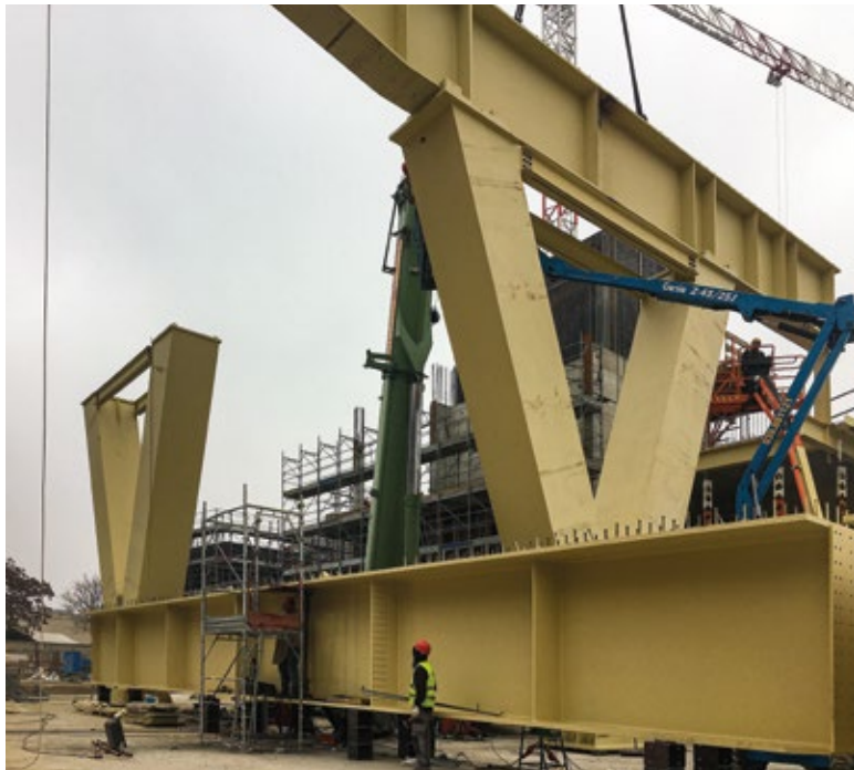
VISTA DEI PILASTRI A "V" IN CANTIERE
