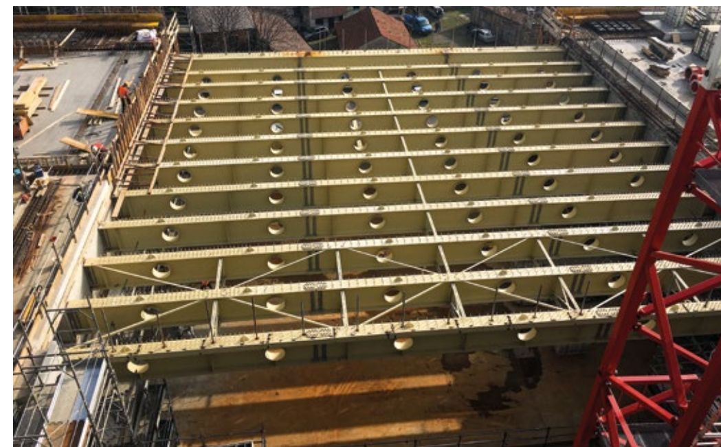
TRAVI DI SOLAIO FORATE
