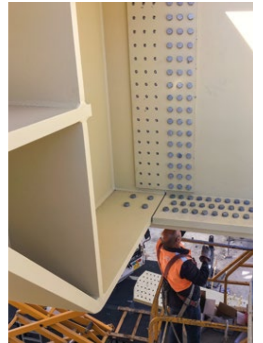
DETTAGLIO DI UN NODO TRAVE-TRAVE
