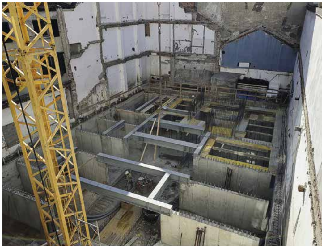
DA SINISTRA: STRUTTURE METALLICHE IN CANTIERE E UTILIZZO DI MICROPALI IN ACCIAIO
