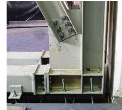
VISTA DELLE OPERE IN ACCIAIO CON TELAI IRRIGIDENTI ED ELEMENTI DISSIPATIVI
