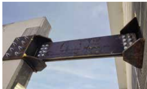
VISTA DEI GIUNTI DI CONNESSIONE IN ACCIAIO
