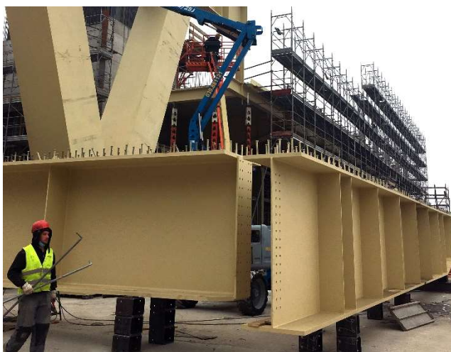
Figura 39 - Vista d'insieme dell'edificio (in alto), vista delle travi composte saldate e degli elementi a "V" (in basso). Foto: Leo Torri; Giulio Boem; SCE Project
